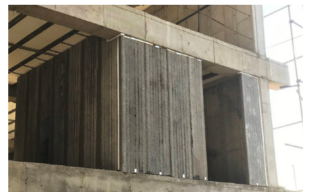
ساختمان مسکونی - جنت آباد
